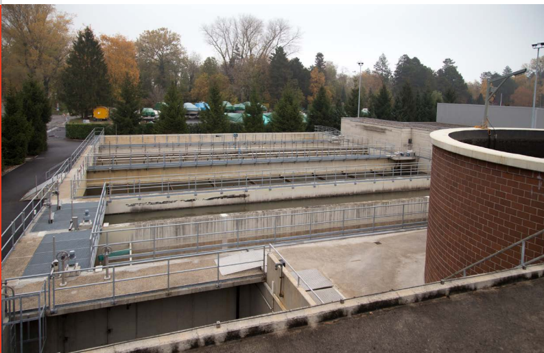
Die ARA Le Landeron klärt die Abwässer von vier Gemeinden der Kantone Neuenburg und Bern.
