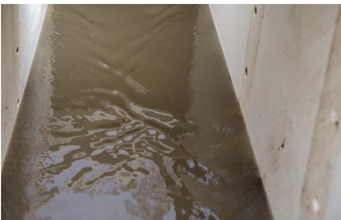
Die Ultraschallsensoren ragen nicht in den Messquerschnitt, damit sich kein Treibgut verfängen kann.
