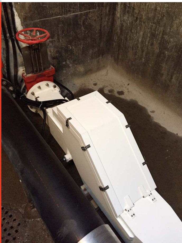
Trocken aufgestellte teilgefüllte pneumatische Abflussregelung im Regenbecken Krummacker. Der dynamische Abflussregler (oben mit offener Wartungsöffnung, unten geschlossen), wurde Ende 2014 eingebaut.
