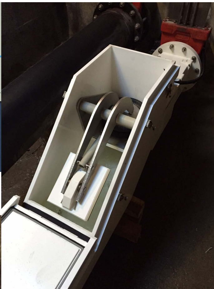
Trocken aufgestellte teilgefüllte pneumatische Abflussregelung im Regenbecken Krummacker. Der dynamische Abflussregler (oben mit offener Wartungsöffnung, unten geschlossen), wurde Ende 2014 eingebaut.
