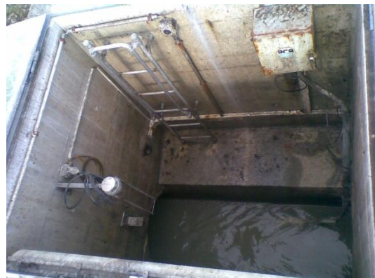
Bestehender Messschacht mit Echolot
