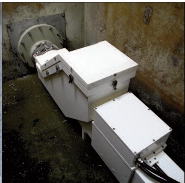
Die im selben Schacht trocken aufgestellte teilgefüllte pneumatische Abflussregelung, die auch den Durchfluss misst.
