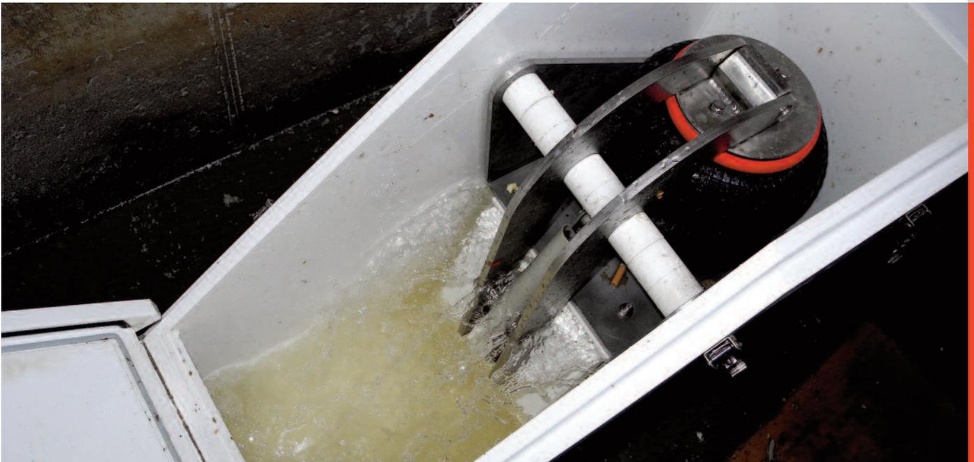
Der neue teilgefüllte pneumatische Abflussregler des Regenbeckens Erlet bei geöffnetem Servicedeckel.
