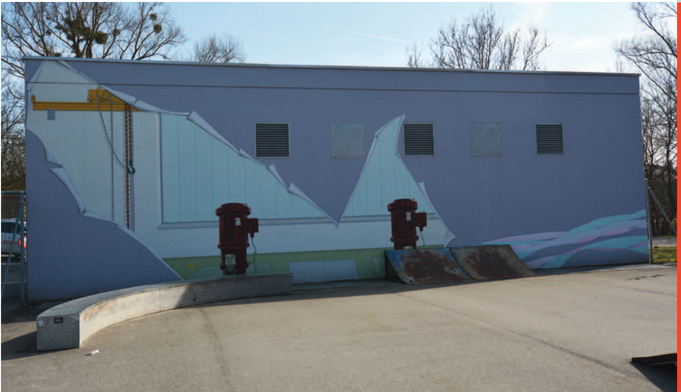
Aussenansicht des Gebäudes, das die Schalt- und Abluftanlage sowie die Pumpen für die Entlastung des Regenbeckens beherbergt.
