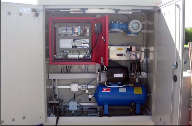
Kompakte Freifeld-Steuerkabine mit Lüftung, Heizung, Druckluftkompressor, Steuereinheit mit Touch-Bedienung und Notdrossel
