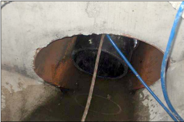
1. Absperrblase setzen
