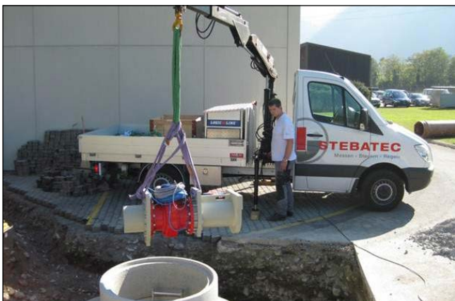
5. Messgerät montieren
