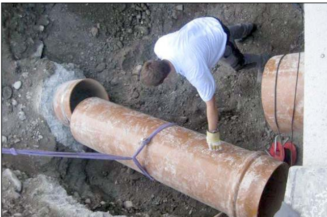
2. Rohr unterbrechen
