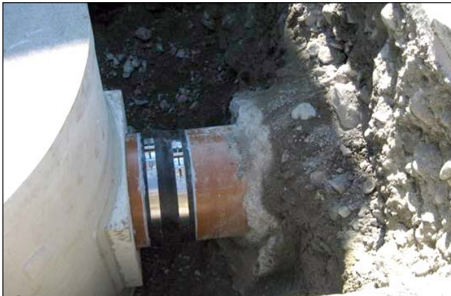
4. Rohr mit Muffe verbinden, Absperrblase entfernen
