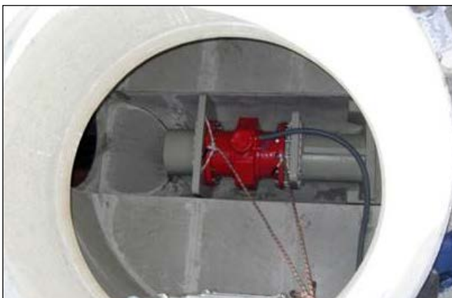
6. Kabel verlegen und anschliessen
