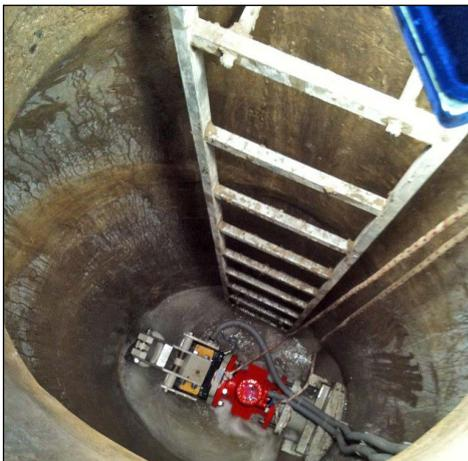
*Pneumatische Abflussregelung NW 150 mit Einhängadaptation. Anschluss an 300 mm Betonrohr in einem bestehenden 90/110 mm Normschacht.*
