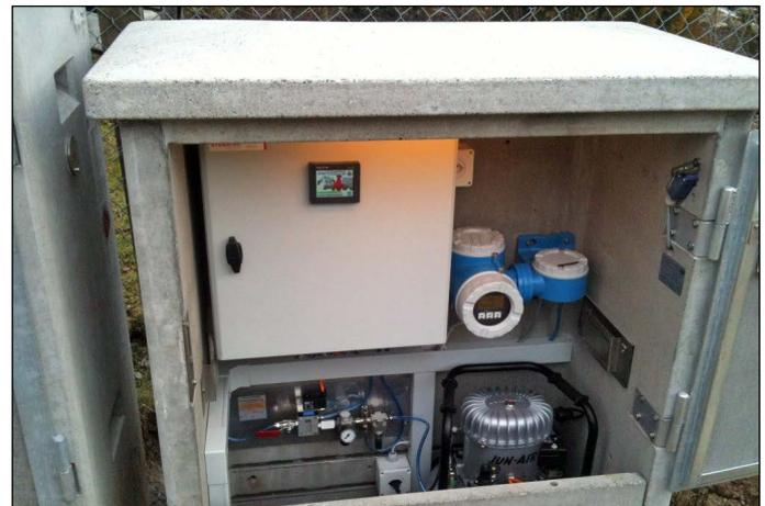
*Steuerkabine zur pneumatischen Abflussregelung. Fernanbindung per kundeneigenem Leitsystem zur Kläranlage.*
